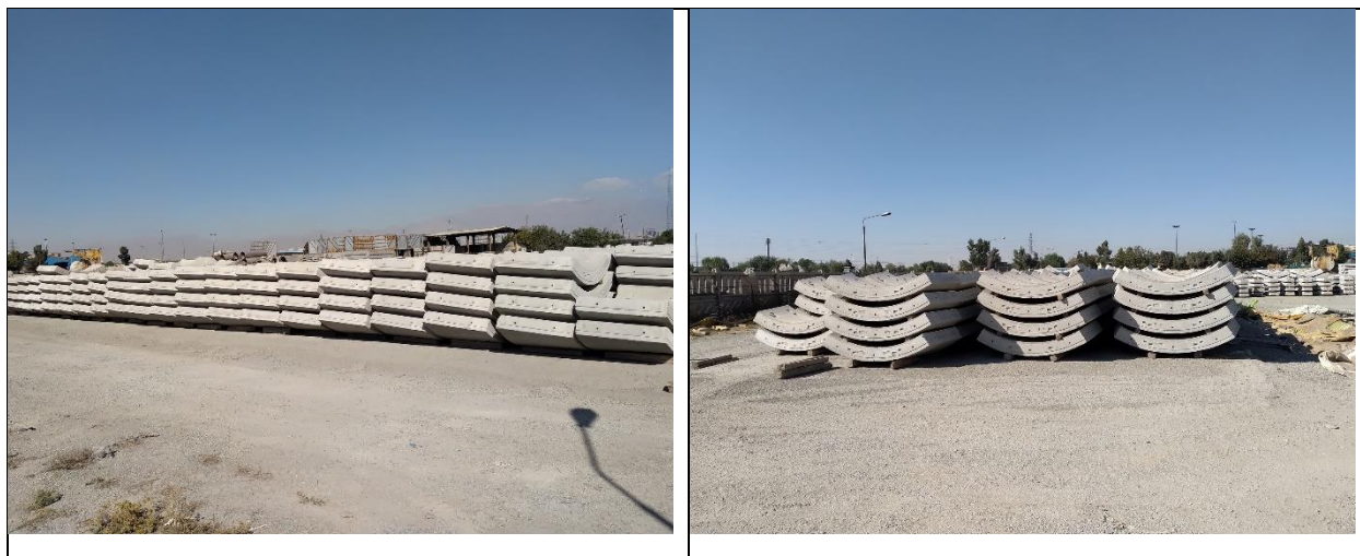
شکل (۸) - دیوی سگمنتها در محیط باز و به وجود آمدن ترکهای ناشی از تنشهای حرارتی و انجماد
